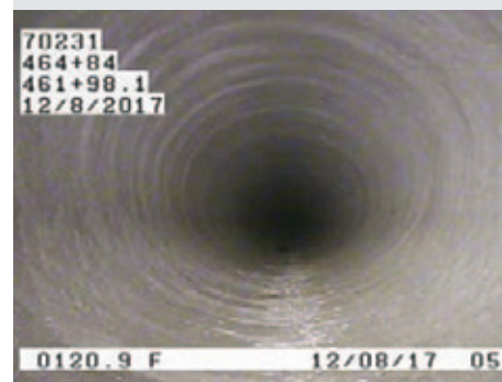
Complete GeoSpray mortar rehab.
