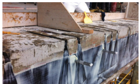
Tyfo® SCH composite anchors
