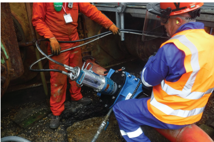
EM Machine milling 120° slot across the pipe
