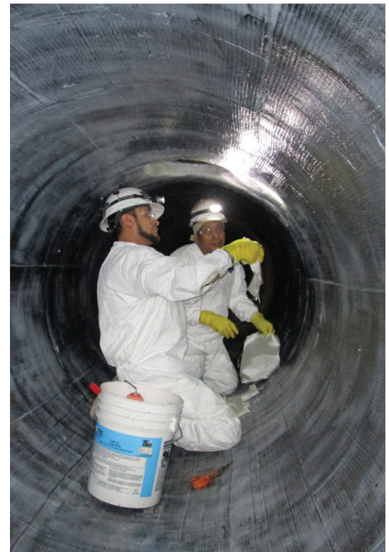
Sistema interno de tuberías Tyfo®
