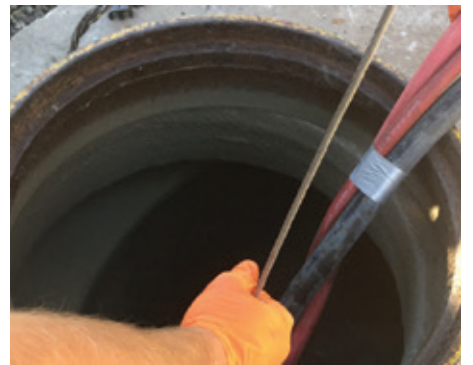
Rehab of manhole.
